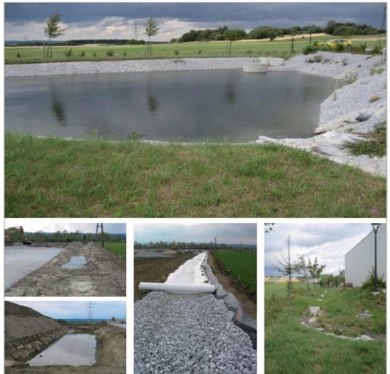
Abbildung 27: Speicherteich, Versickerungsmuldenrigol (Bild unten Mitte) und Versickerungsmulde (Bild unten rechts)
