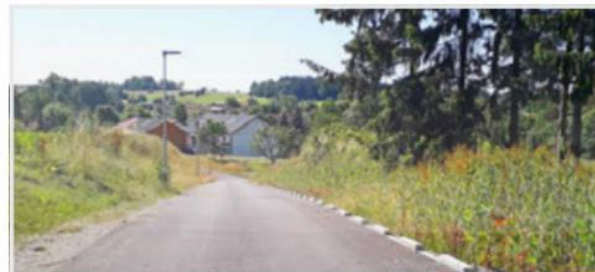
Abbildung 10 | Lineare Retentions- und Versickerungsmaßnahme durch abwechselnden Hoch- und Tiefbord
