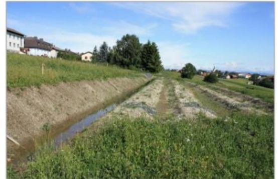
Abbildung 25: kaskadenförmige Sickermulden, kurz nach deren Fertigstellung
