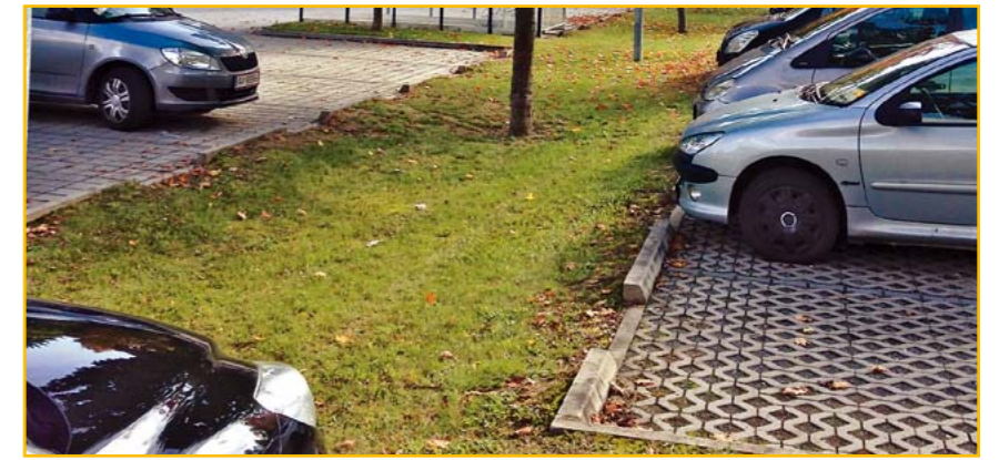
1 Rasenmulde mit Humusfilter Parkplatzentwässerung über eine Sickermulde
