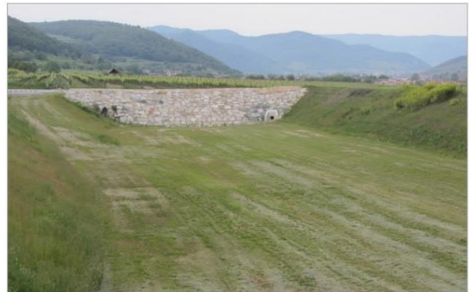
Abbildung 40: Rückhaltebecken Mautern Weinbergstraße kurz nach Fertigstellung
